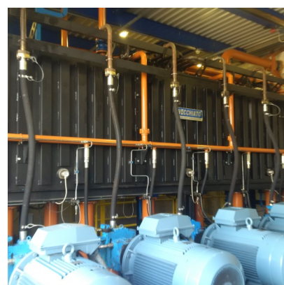
Centralina oleodinamica e pompe EATON a pistoncini assiali
